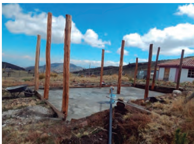
Figura 6.- Plataforma de cemento y palos de eucalipto para los módulos de Chiara y Quinua
