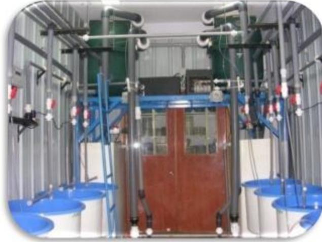
**Figura 19.** Biofiltros, conexiones, tanques “pulmón” del sistema de recirculación.
