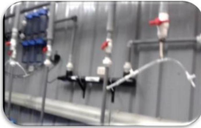
**Figura 20.** Cunos y lámpara de radiación ultravioleta del sistema de recirculación.
