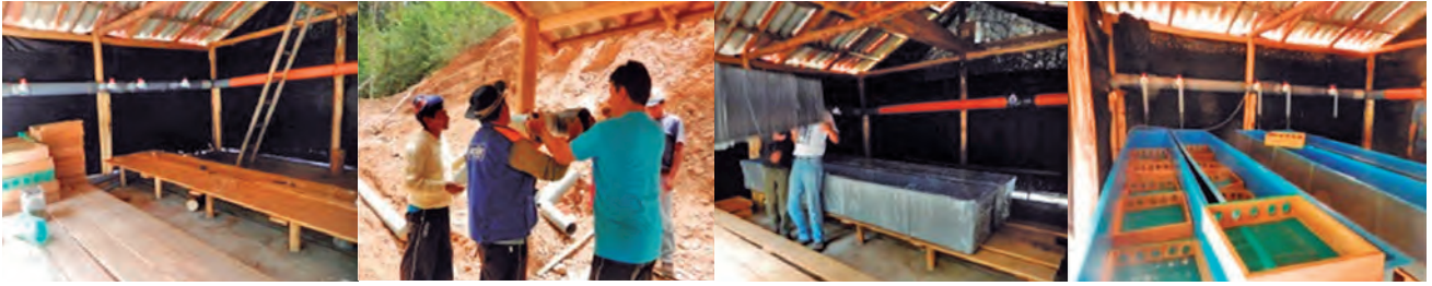
Construcción e implementación del módulo pre-fabricado
