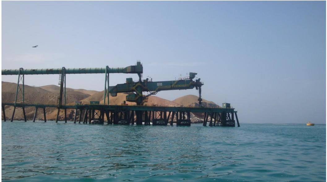
Figura 33.- Brazo mecánico y muelle para el embarque de concentrado. Punta Lobitos-Huarmey.
